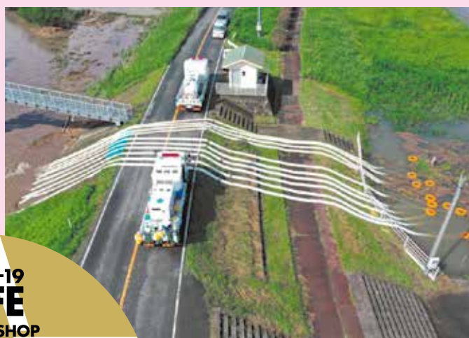
陣屋川で排水作業を行う 排水ポンプ車
