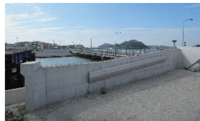
主要地方道 直方芦屋線 西祇園橋 (芦屋市)
