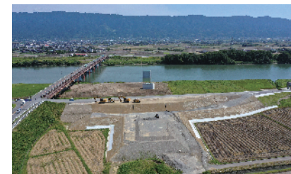
主要地方道 甘木田主丸線 両筑橋 (朝倉市~久留米市)
