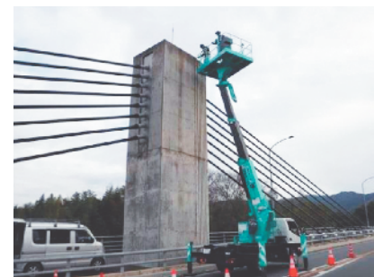
高所作業車による橋梁定期点検の状況
