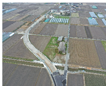
主要地方道 瀬高久留米線 (筑後市)
