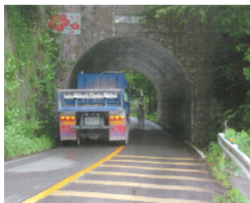
一般国道385号 南畑バイパス (那珂川市)
