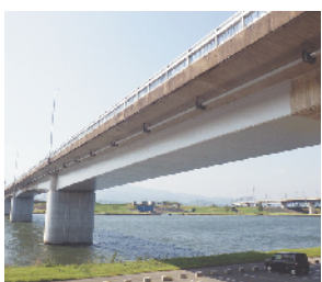
市道A1号線(長門石橋) (久留米市)
