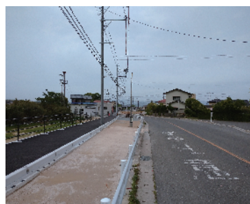
主要地方道 直方行橋線 (直方市)
