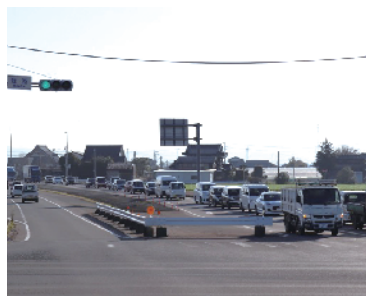
一般国道442号 大木大川バイパス(4車線化) (大木町～大川市)
