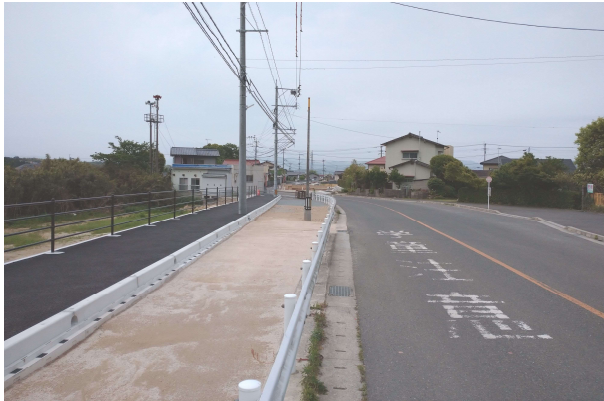
主要地方道 直方行橋線 道目木工区 (直方市)
