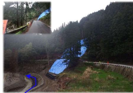
※仮舗装・ブルーシートで法面を保護・大型土のうで法面の土留
