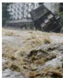
大雨による増水で崩落した鬼怒川プラザホテル
