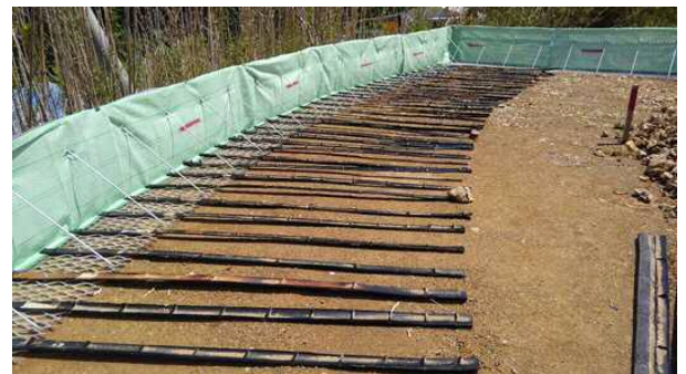
竹補強材の設置状況
