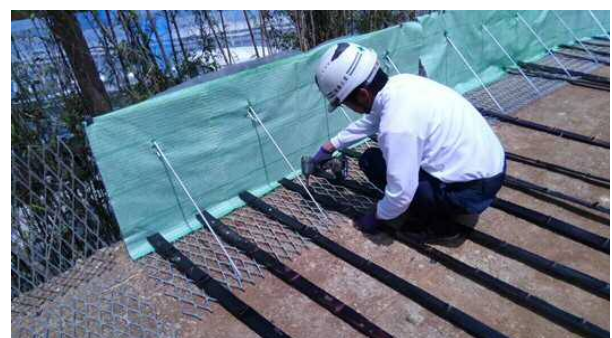
竹補強材取付け状況
