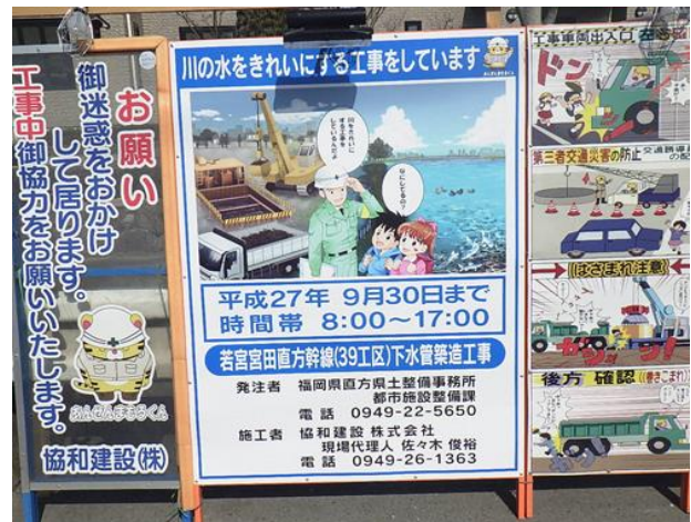
工事看板設置状況
