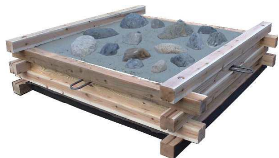
コンクリート打設完了状況
