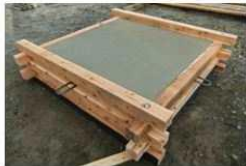
コンクリート打設完了状況
