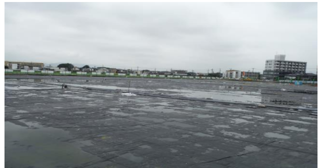
真空運転状況
