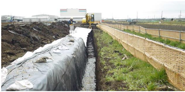
端部掘削状況
