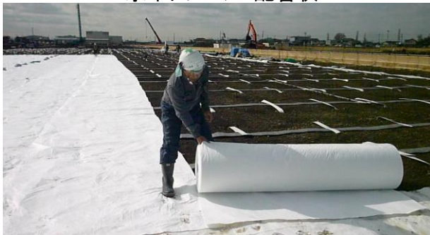
保護シート敷設状況
