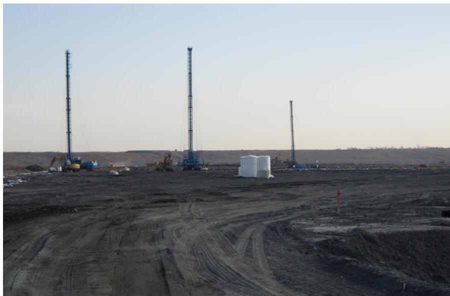
鉛直ドレーン打設状況
