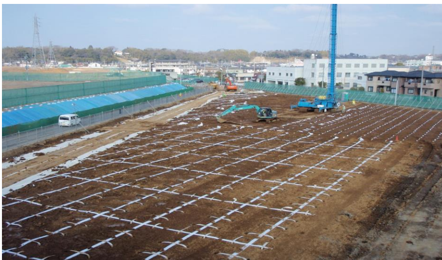
鉛直ドレーン打設状況
