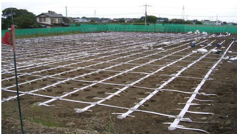
水平ドレーン布設状況
