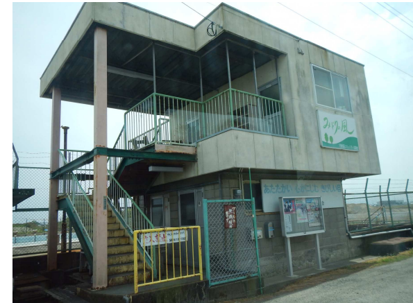
事務所：下妻小学校プール管理棟
