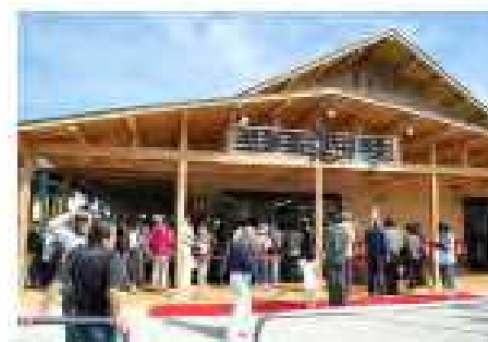
▲ 川の駅船小屋「恋ぼたる」 (物産館・温泉館)
