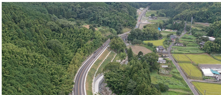
①、② 一般国道322号 八丁峠道路・千手バイパス (嘉麻市・朝倉市)
