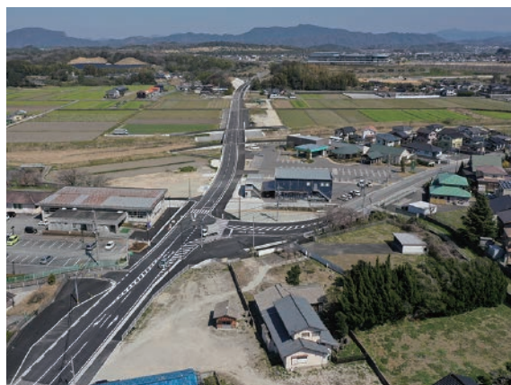
⑥ 一般県道 豆田稲築線 土師工区 (桂川町)
