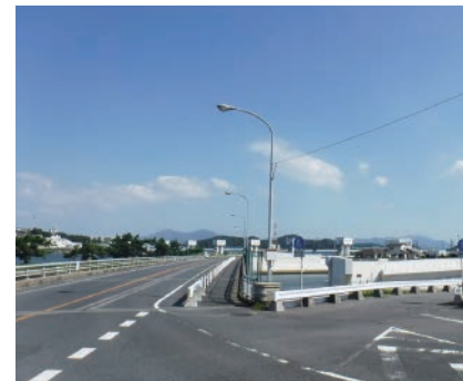
主要地方道 直方芦屋線（西祇園橋） （芦屋町）
