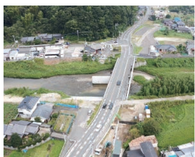
一般国道385号 那珂川拡幅Ⅱ期 (那珂川市)
