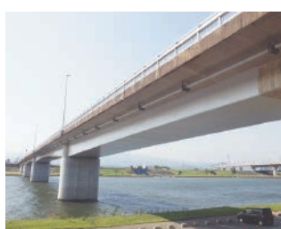
市道 A1号線(長門石橋) (久留米市)
