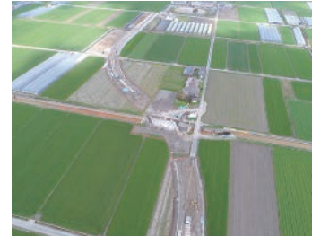
主要地方道 瀬高久留米線 (筑後市)
