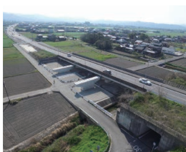
一般国道443号 三橋瀬高バイパス(4車線化) (柳川市~みやま市)
