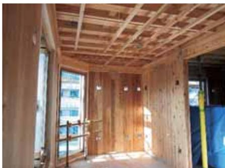
CLT は構造材（耐力壁）として使用
