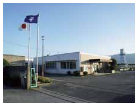
復旧した庁舎全景
