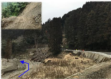
道路啓開状況
