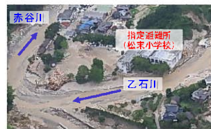
土砂・流木により被災した避難所
