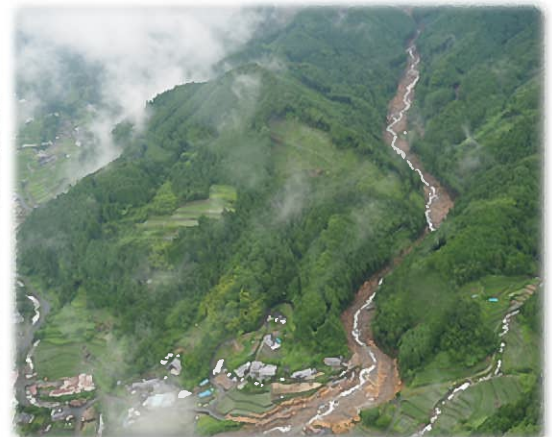
土石流(東峰村宝珠山)【写真:国土地理院提供】
