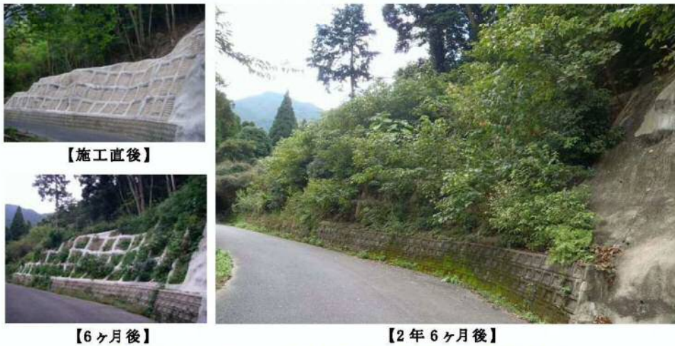
『イースターマット』の施工例(久留米土木事務所)
