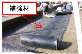
②ロックデム敷設
