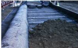
④盛土材撤きだし
