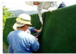
⑥防護マット設置
