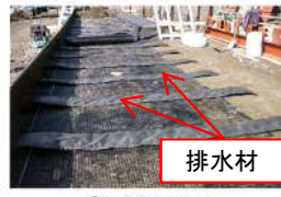
③板状排水材設置
