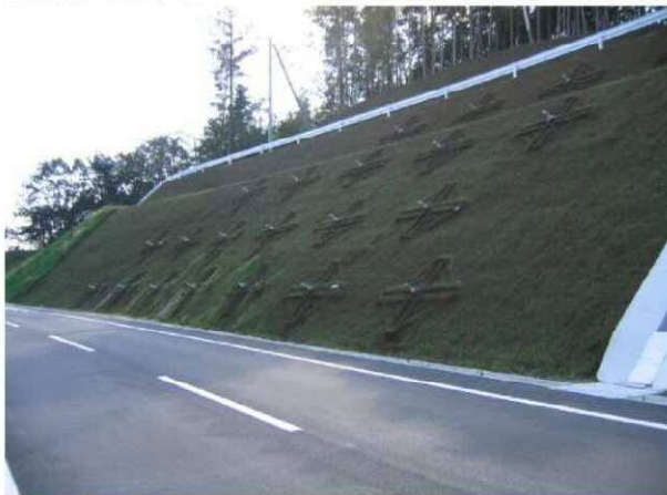
写真-1 植生基材吹付直後
