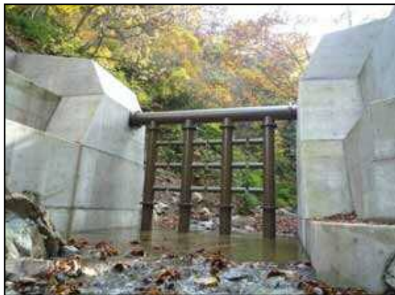
写真-2 長井ダム折草沢跡地整備工事
