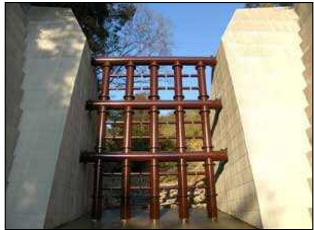
写真-1 横谷川2号災害関連緊急砂防工事
