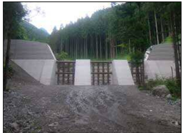
写真-3 砂防激甚災害対策緊急(天狗沢)
