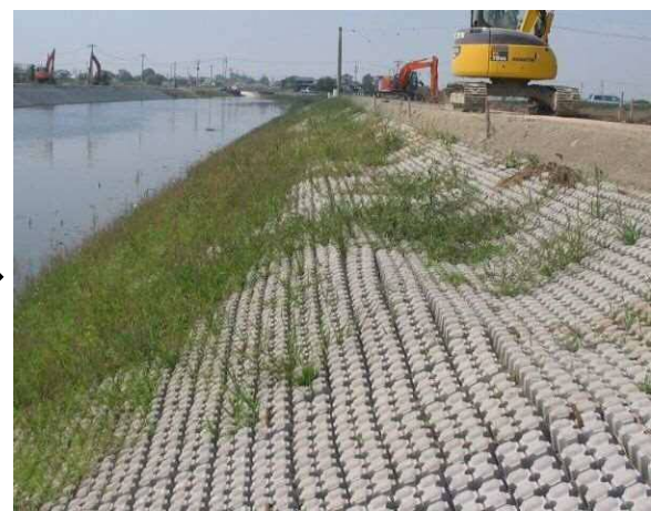
植生状況1(ソルコマット標準型敷設後1ヶ月経過)
