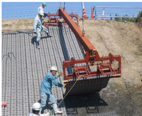
ソルコマット施工状況
