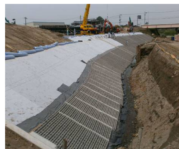
ソルコマット施工状況
