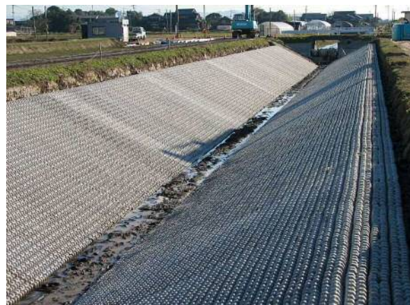
写真-2 敷設完了
