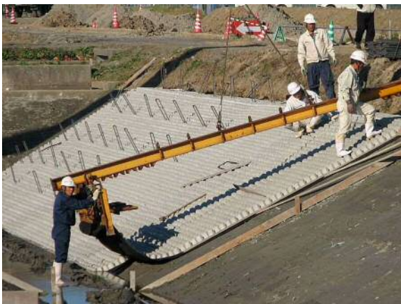
写真-1 敷設状況
