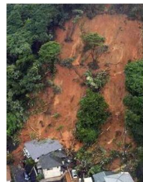
急傾斜地復旧状況 奥田地区（北九州市）
