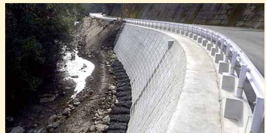
復旧工事を行い、整備された国道500号
