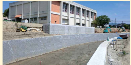
復旧工事により、護岸などを整備
