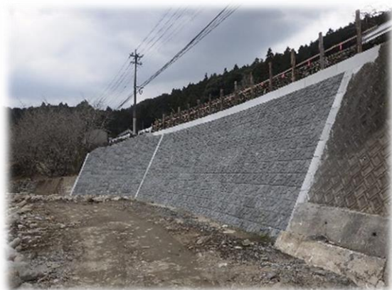
河川の改良工事
