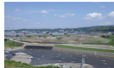
<河川の護岸整備>
