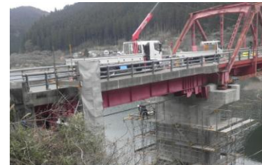
<橋梁の老朽化対策工事>
