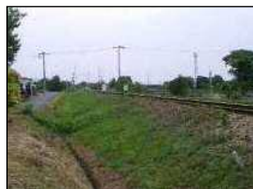
保全対象(鉄道)
