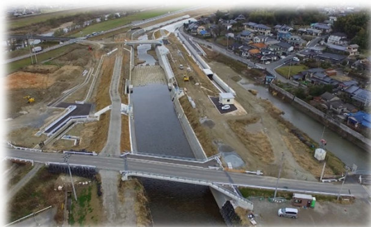
河川の改良工事
