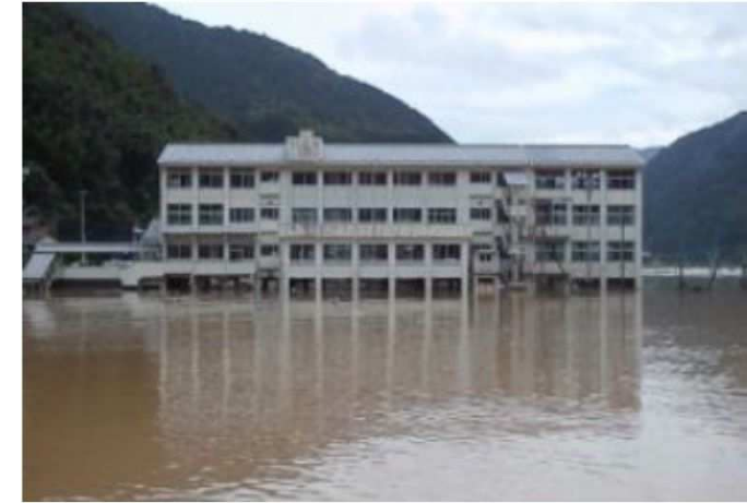
避難所2階の浸水（平成26年8月：徳島県）
