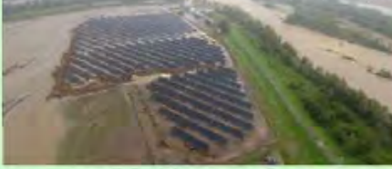
堤防の決壊による氾濫状況 (札内川:北海道帯広市)
