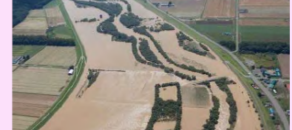
越水による堤防の法崩れ(常呂川)
