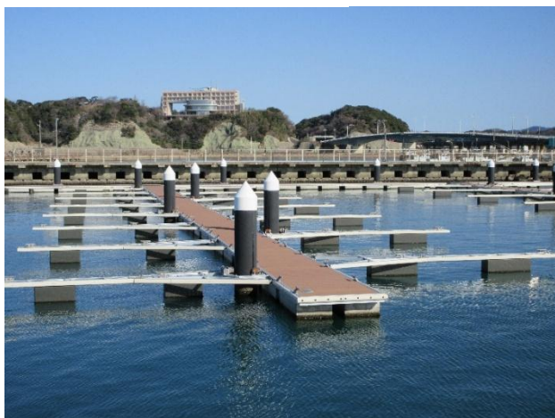
<係留施設（県整備）>
