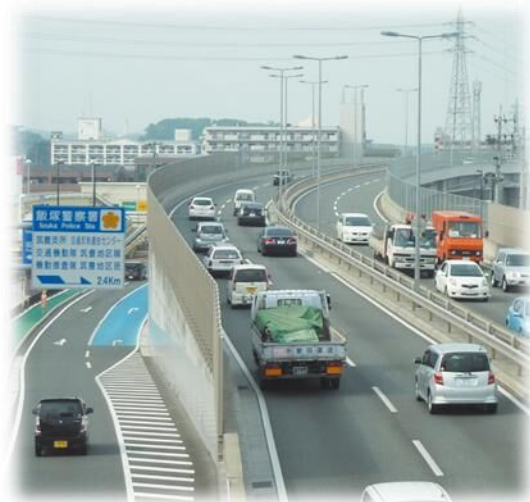
橋や道路の整備
