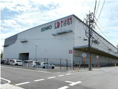
佐賀県鳥栖市（大型物流施設）
