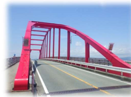
<橋りょうの補修>
