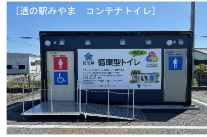
避難所環境の整備(コンテナトイレ)
