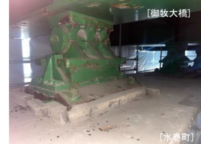
道路橋の老朽化対策
