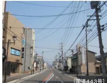
無電柱化(緊急輸送道路)
