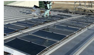
福岡空港国際線 ターミナルビル屋根
