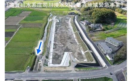
調節池の整備
