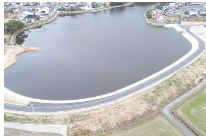
防災重点農業用ため池の整備
