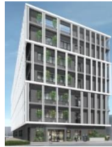
エフラボ九大病院
