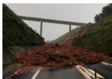
平成30年7月豪雨における被災状況
