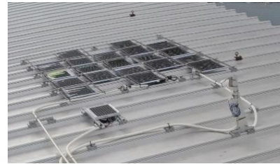
博多駅ホーム屋根
