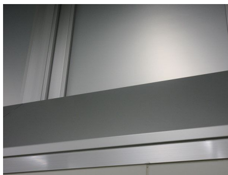
掃除がしやすいよう 上部を斜めにした壁
