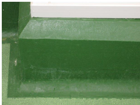
掃除がしやすいようR形状にした段差部分
