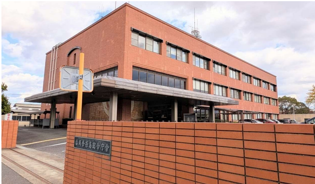
福岡県糸島総合庁舎 外観
