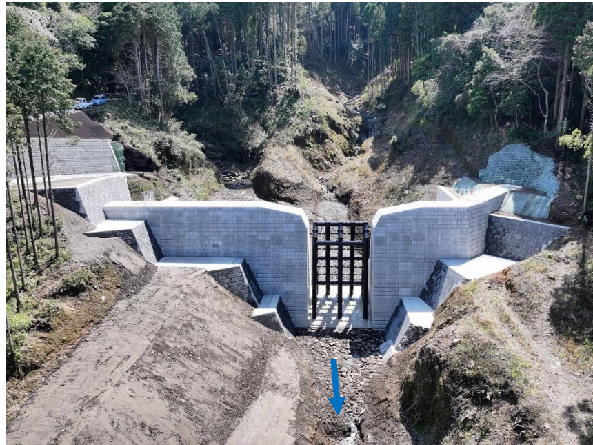
対策工事 施工中
