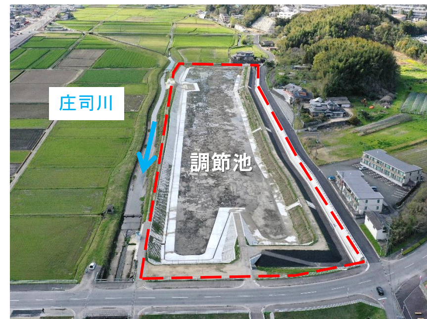
対策工事完了
