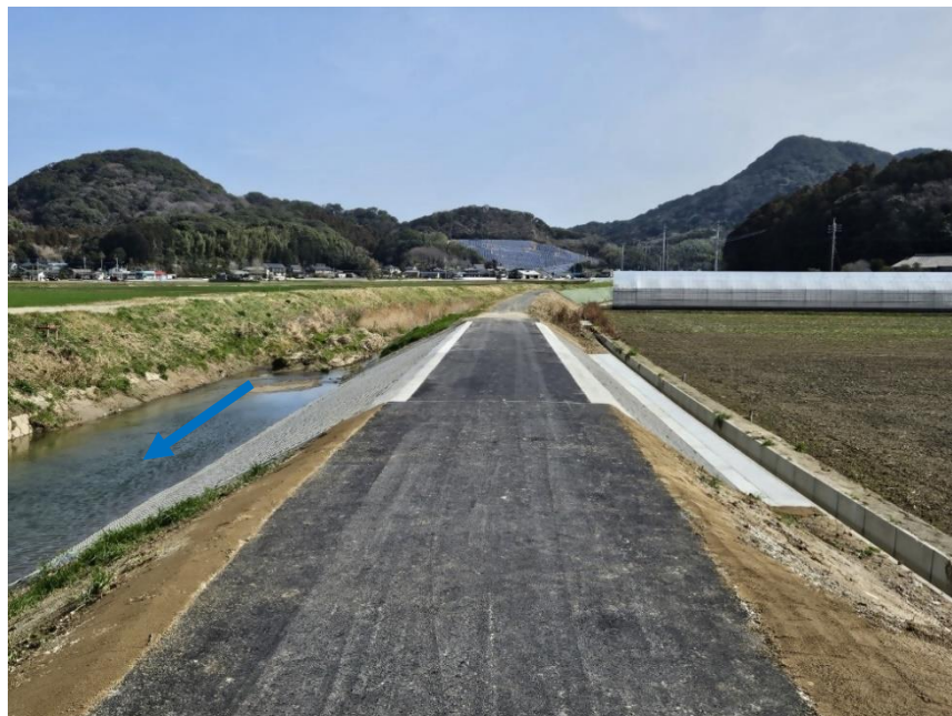
復旧工事完了
