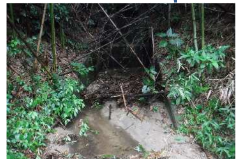
【令和元年施工】 土砂撤去
