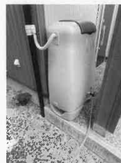
雨水貯留タンクの 設置事例（250ℓ）
