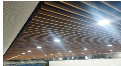
県有施設のLED照明更新（イメージ）
