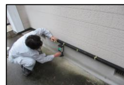
基礎配筋をチェック
