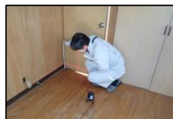
床の傾きをチェック
