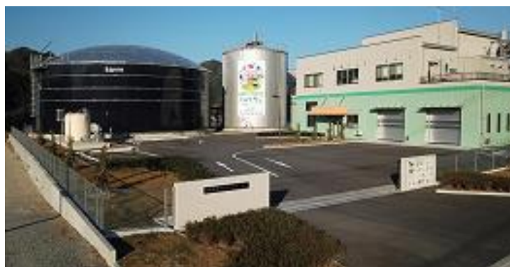
■ バイオマスセンター「ルフラン」（みやま市）
