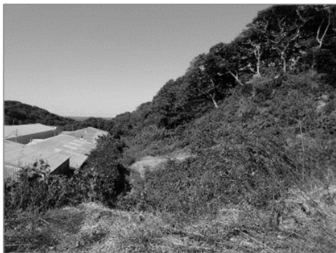
図7 野鳥侵入防止対策(樹木伐採)
