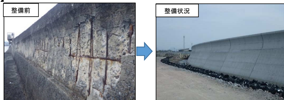
海岸堤防等老朽化対策【三毛門沓川海岸(豊前市)】
